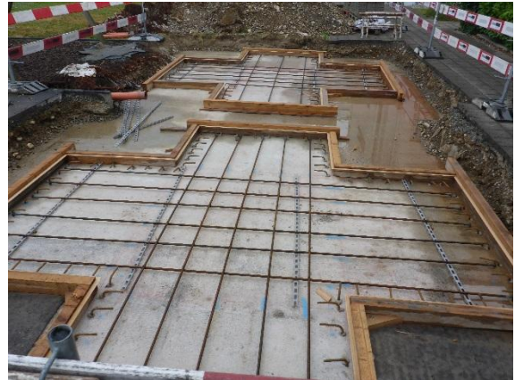
Abbildung 9: Verlängerung der oberseitigen Bewehrung mit ancoFix
