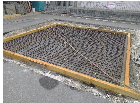
Abbildung 7: Eingebaute Bewehrung im Bereich Aufbeton
