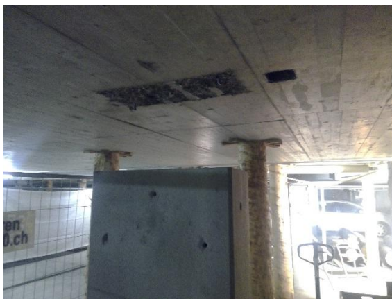
Abbildung 2: Spriessung und ausgebauter Stützenkopf
