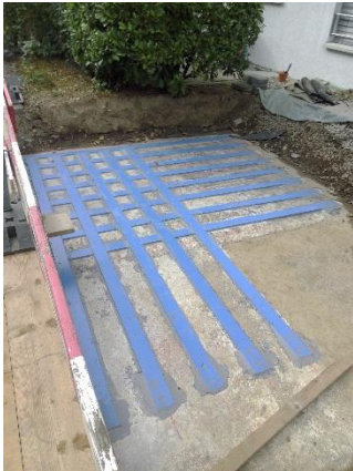
Abbildung 8: Verlängerung der oberseitig Bewehrung mit Stahl-Lamellen
