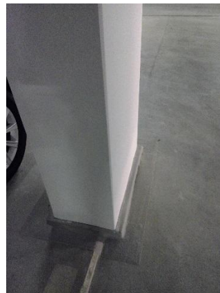
Abbildung 11: Brandschutzverkleidung um Stahlmantel und Abdichtung Stützenfuss
