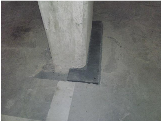
Abbildung 4: Fussplatte für Lastabtrag über Mantel
