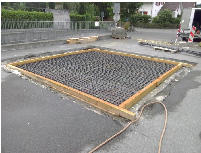
Abbildung 12: Aufbeton mit gegenläufigem Gefälle bei Besucherparkplätzen
